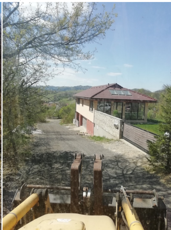
stav po rekonštrukcii
