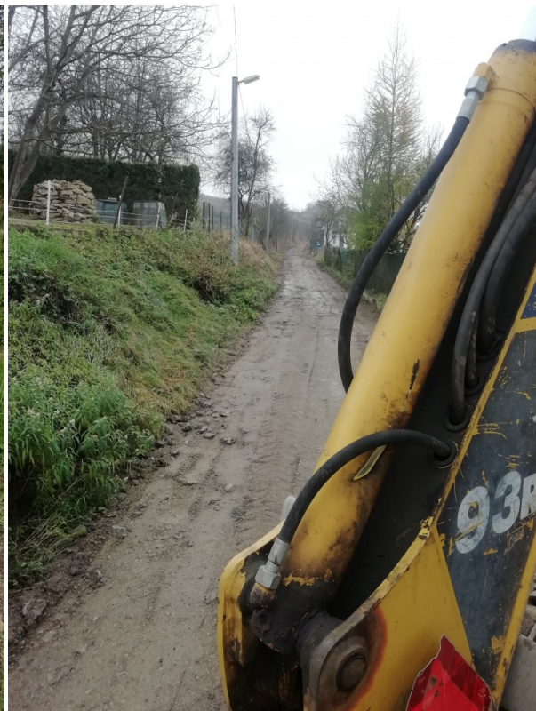
stav po rekonštrukcii
