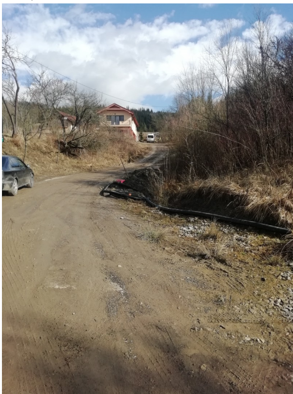
stav pred rekonštrukciou
