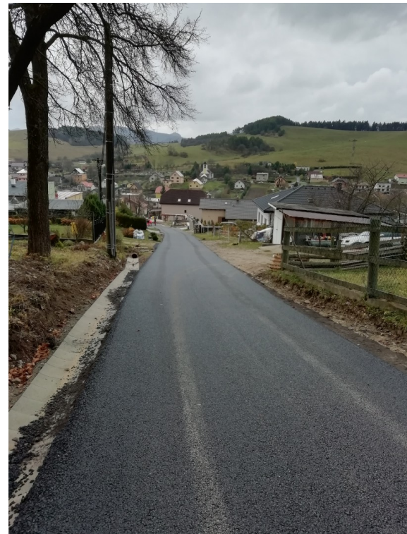
stav po oprave
